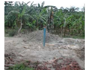
Fehlgeschlagene Brunnenbohrung
