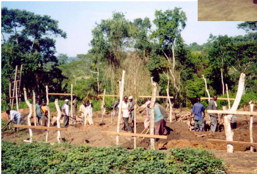
Bild unten: Arbeiter der Firma HOIMA beim Graben der Grundfeste. Es muss alles mit der Hand gemacht werden.
