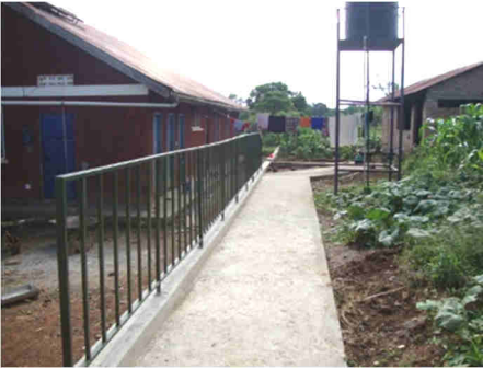
Die Rampe führt vom Haupteingang hinter das Haus zu den Toiletten.
