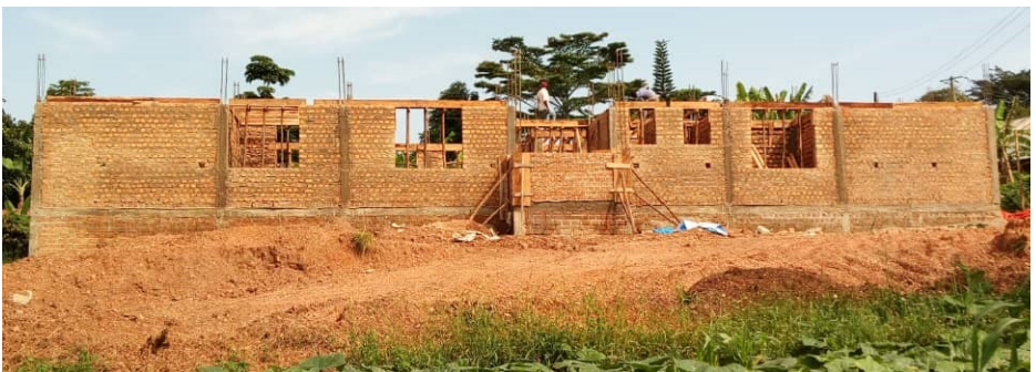
Baufortschritt am 7. Dezember 2020
