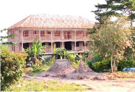
Vorderansicht: Rohbau mit dem Dachstuhl
