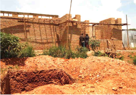
Die Arbeit am Rohbau ging gut und unfallfrei voran.
