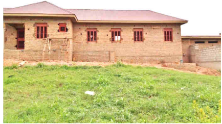
Rohbau mit Fensterrahmen und Dach. Da war noch einiges zu tun!
